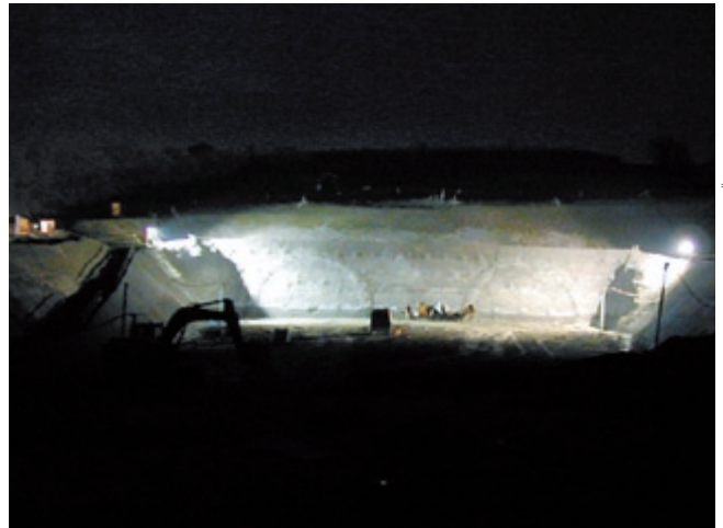
Voreinschnitt Chorherrn, zukünftiges Westportal Wienerwaldtunnel
