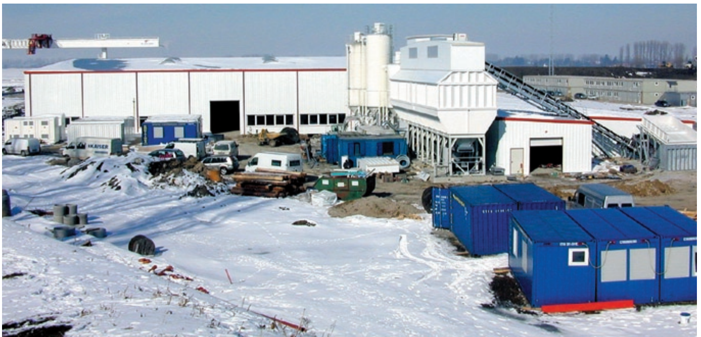
Baustelleneinrichtung Wienerwaldtunnel/Westvortrieb
